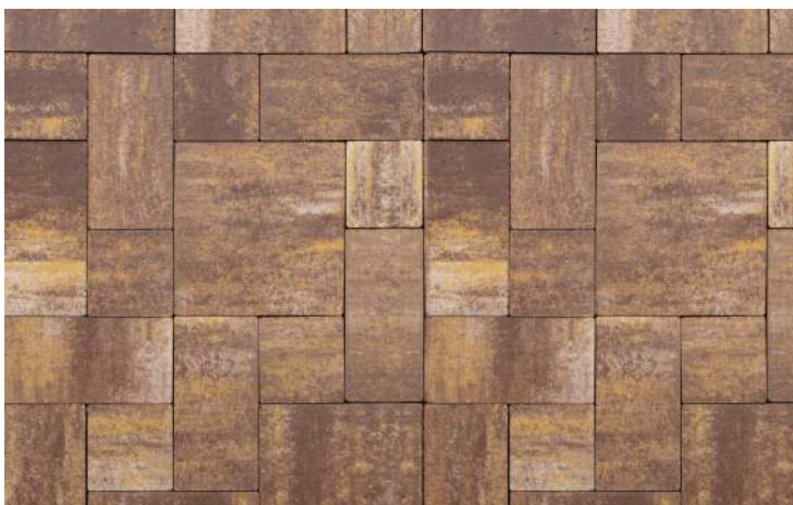
Рис. 3 Правильно укладена бруківка без сколів та пошкоджень кромки
